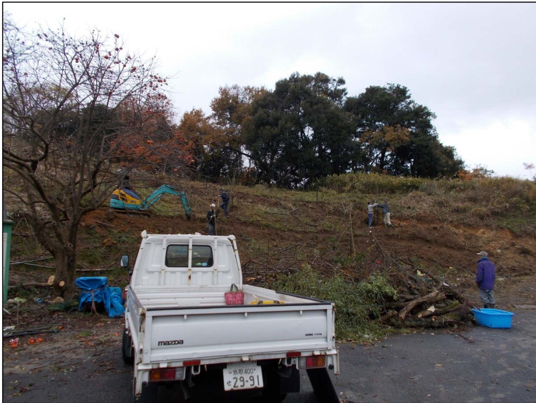
斜面に3段のテラスをユンボで整備作業
